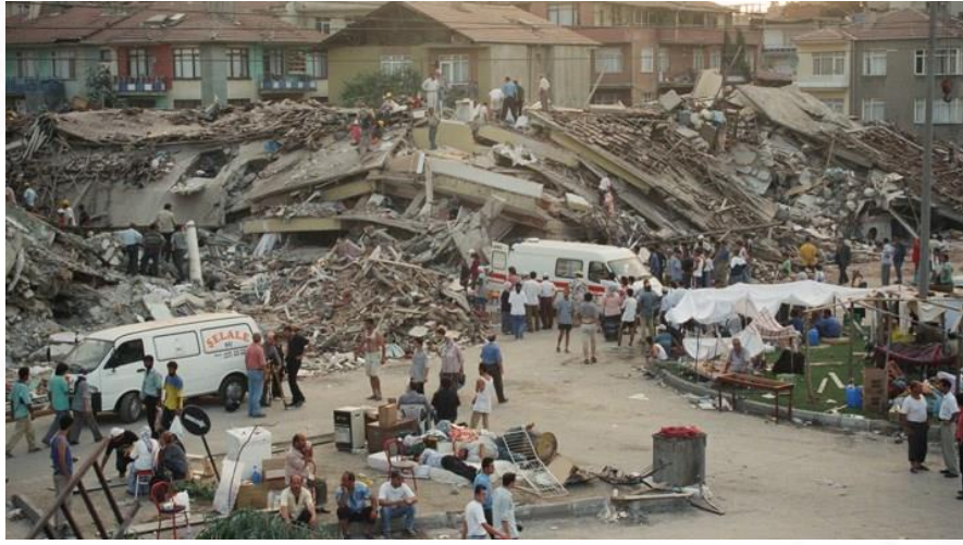
Resim – 1: 1999 Marmara Depremi Sonrası Afet Ortamının Keşmekeşi. 4
