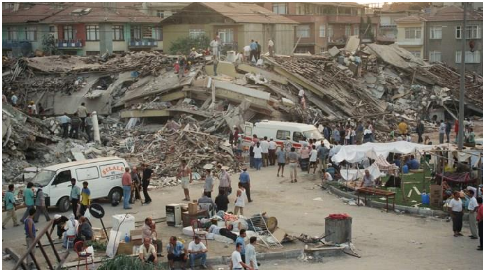
Resim – 1: 1999 Marmara Depremi Sonrası Afet Ortamının Keşmekeşi. 1
